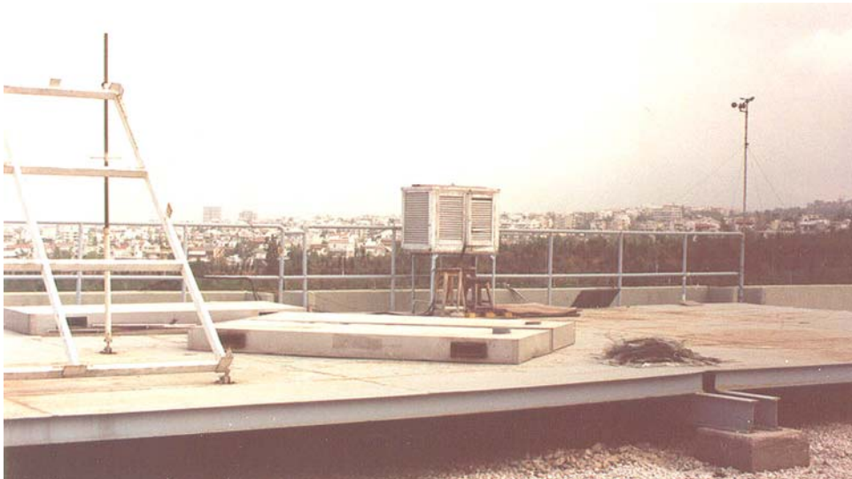
Σχήμα 4 Πλατφόρμα στο Δώμα του Ηλιακού Εργαστηρίου
